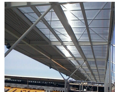
PC kanalplater til overlys tribunetak, Åråsen Stadion
